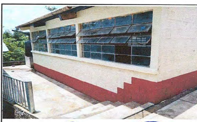
FOTO 6 APLICACIÓN DE PINTURA EN LAS PAREDES FINALIZADA
